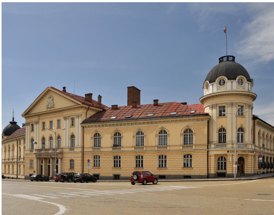
Фасада на сградата на БАН от северозток
