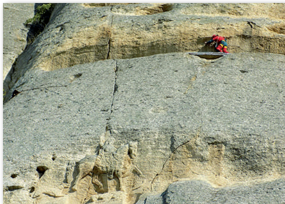
Инструментален мониторинг на опасни пукнатини, застрашаващи паметника на културата „Мадарски конник“
