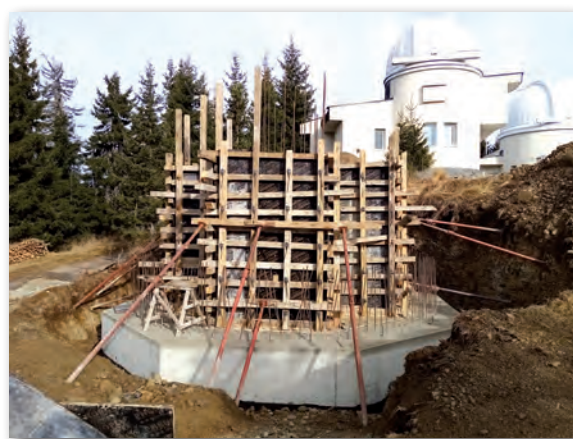
Фундаментът на новия 1,5 м телескоп
